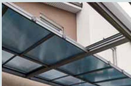
Bei starkem Wind und Sturm müssen die Lamellen geöffnet bleiben, damit sie nicht beschädigt werden.
