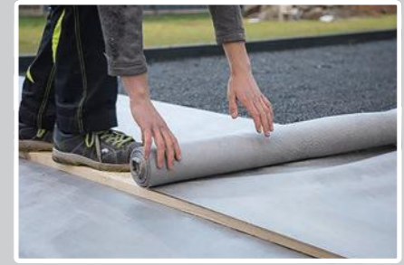
6. Verlege Vlies als Schutz gegen Unkraut auf dem Splitt.
