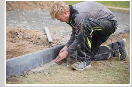
3. Setze Kantensteine zur Einfassung und Stabilisierung der Terrasse.
