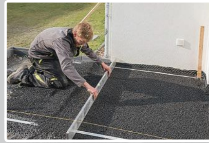
5. Ziehe die geschüttete Edelsplittschicht mit leichtem Gefälle ab.
