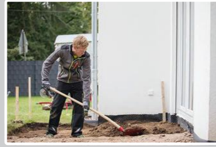
2. Die abgesteckte Fläche kann nun ausgeschachtet werden.
