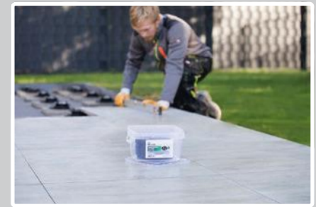
9. Jetzt kannst Du die Terrasseplatten verlegen.
