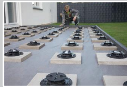
8. Stelle auf jede Platte ein Stelzlager.
