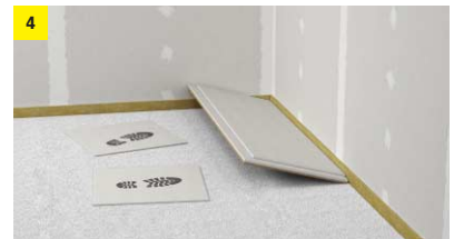
4 Verlegen der fermacell® Estrich-Elemente
