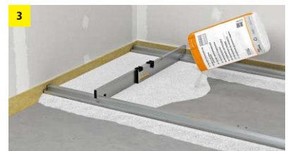
3 fermacell® Ausgleichsschüttung einbringen
