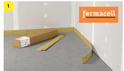
1 Anbringen der Randdämmstreifen
