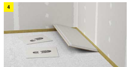
Verlegen der fermacell® Estrich-Elemente
