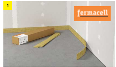
Anbringen der Randdämmstreifen
