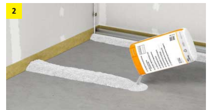
2 Anlegen der Dämme
