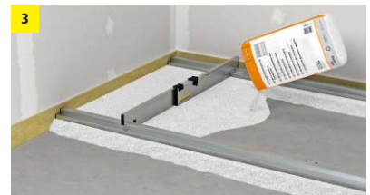
fermacell® Ausgleichsschüttung einbringen
