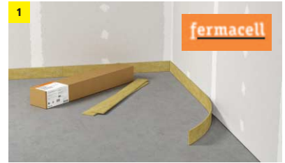
Anbringen der Randdämmstreifen
