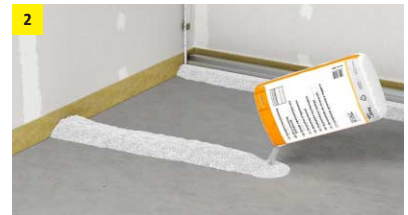
Anlegen der Dämme
