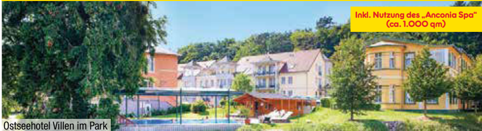
Ostseehotel Villen im Park
